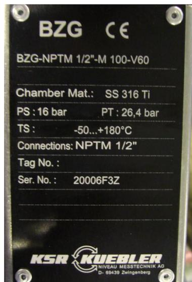
Фирменная табличка закреплена на передней вертикальной поверхности контрольного мерного бачка.
